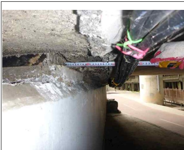
내 용 연단 거리 측정 내 용 점검망치를 이용한 구조물상태확인
