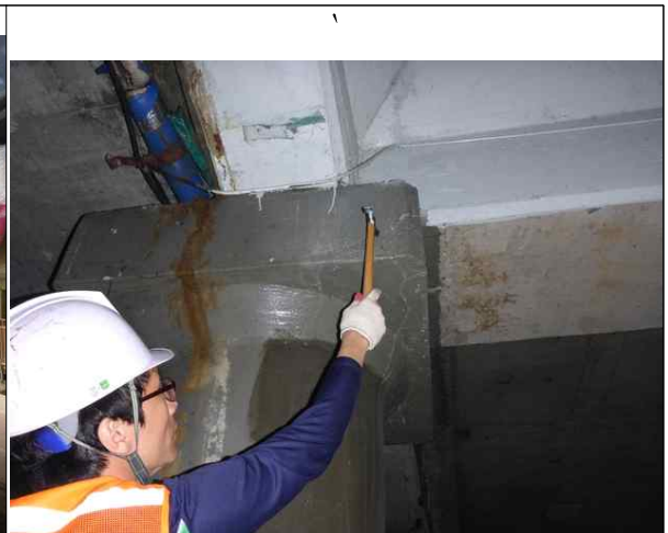
내 용 연단 거리 측정 내 용 점검망치를 이용한 구조물상태확인
