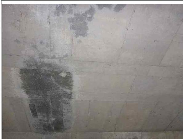
사진설명 바닥판하면 전경
