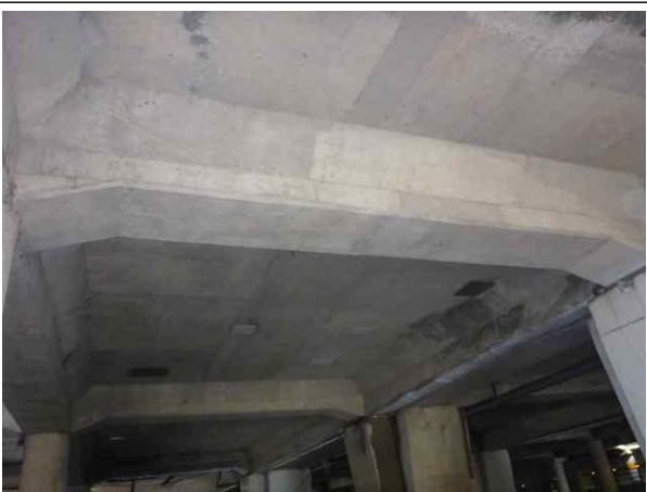
사진설명 거더 전경
