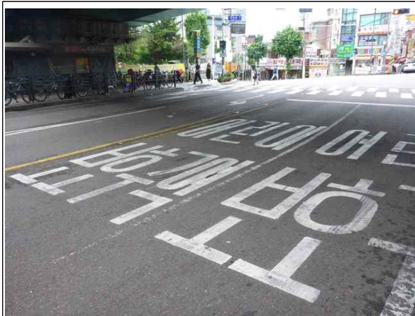
사진설명 교면포장 전경
