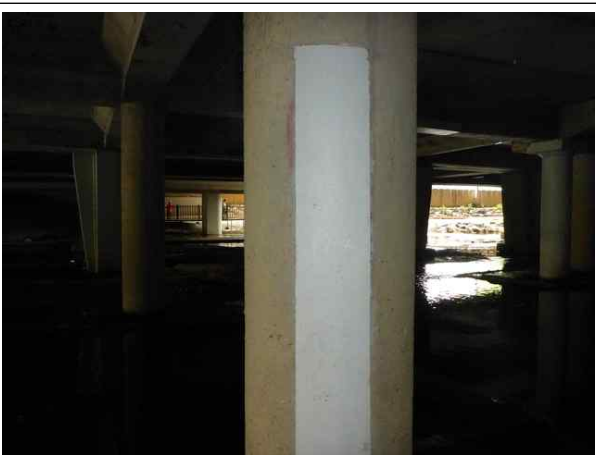
사진설명 교각 전경
